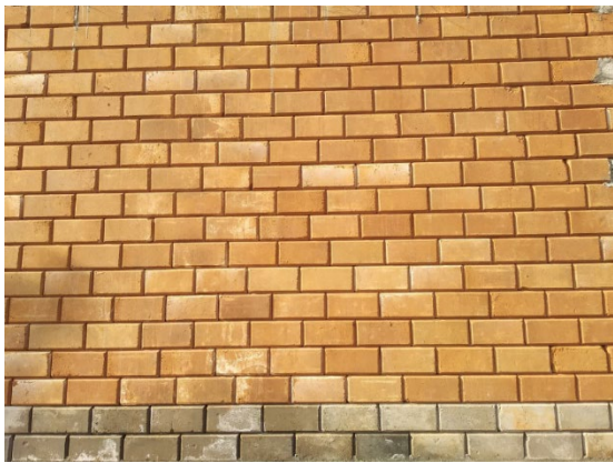
Fig: CSEB Interlock blocks
